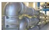
Les gammes Transair® en aluminium et en acier inoxydable peuvent être utilisées pour des applications de vide jusqu'à 1 mbar de pression absolue au point d'utilisation.
