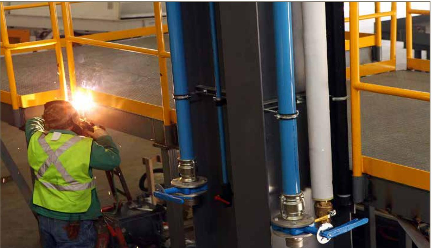
Diamètre des tubes Transair® : 76 mm (3")
